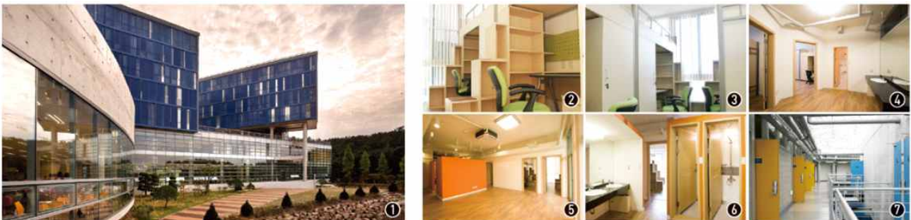
① 기숙사(생활관) 외부 ② 내부(2인실) ③ 내부(3인실) ④ 내부(6인실) ⑤ 내부(16인실) ⑥ 사무원장(16인실) ⑦ 복도
